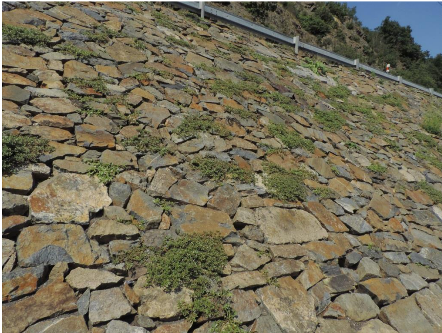
Dlažba nasucho – správná skladba, do ideálního provedení chybí výplň spár
