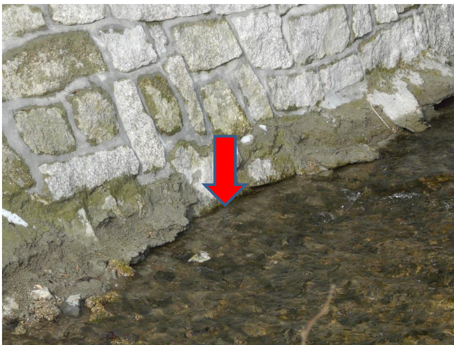
Dlažba z lomového kamene do betonového lože ve sklonu větším, než 1:1 – chybí založení konstrukce na zához nebo dlažbu dna. Díky dobře vyvinuté dnové dlažbě ale i tak konstrukce vydržela řadu desetiletí
