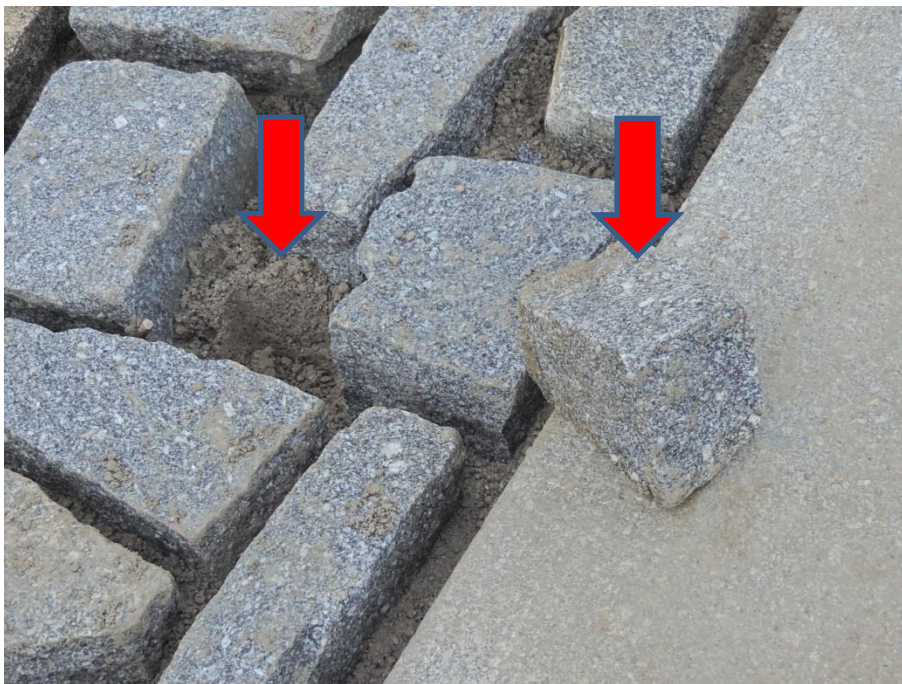
Dlažba do betonového lože – nedostatečná tloušťka klínů (Při předepsané tloušťce kamenů 300 mm hloubka klínu nepřesahovala 150 mm, v konstrukci jich posléze bylo zjištěno asi 15). Závadu lze zjistit nejpozději bezprostředně po položení dlažby před dospárováním šlápnutím na hranu klínu, který se při nedostatečné tloušťce snadno vyvrátí.
