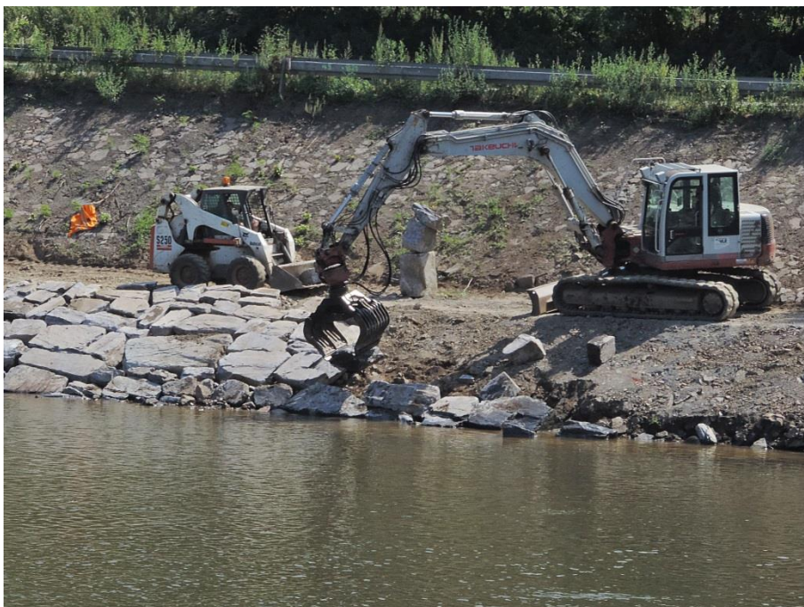
Pokládka strojně rované dlažby. Místo na záhozovou patku se osazují spodní kameny do rýhy u paty svahu. Pod silnicí je svah opevněn dlažbou z lomového kamene nasucho, která byla dost pravděpodobně položena na počátku 20. století
